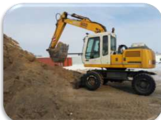
Экскаватор ЭО-LEBHERR (Германия)
