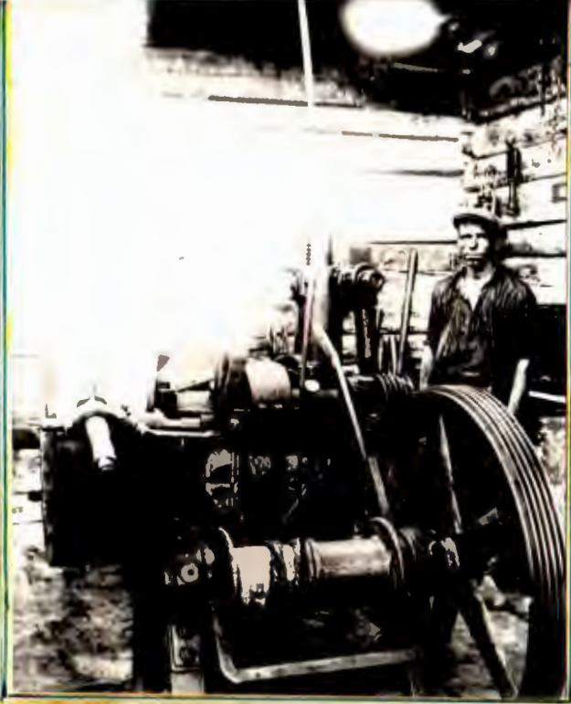
14. КОУНРАД. Лучший в то время буровой станок "Крелиус". 1933 г.
