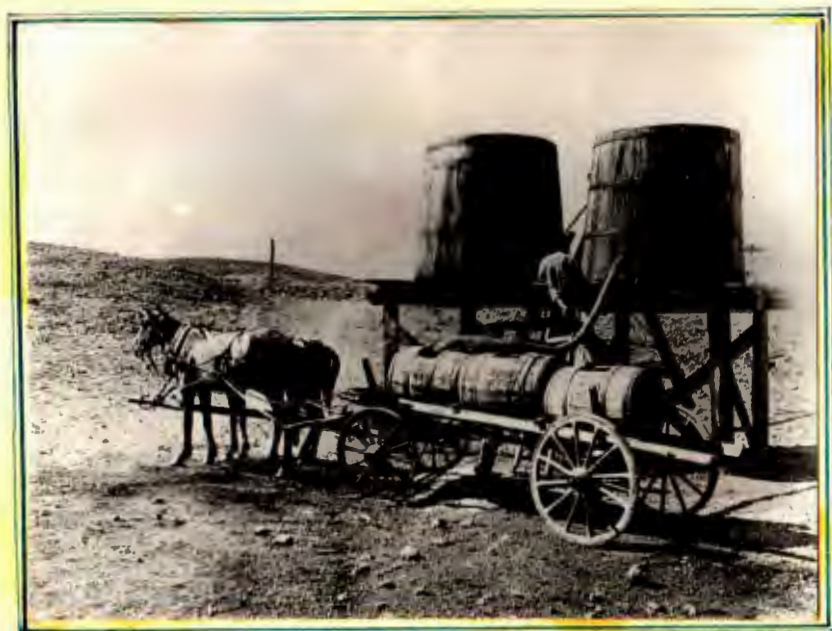
12. КОУНРАД- Шахта №2. Резервные баки воды для бурения- 1932 г.
