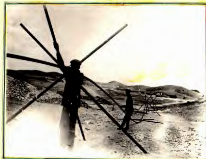
13. КОУРАД- Водоснабжение. Уклад- ка водопровода. 1932 г.
