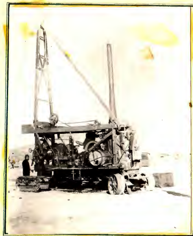
9. КОУНРАД- Разведка станком КИСТОНА, 1933 г.
